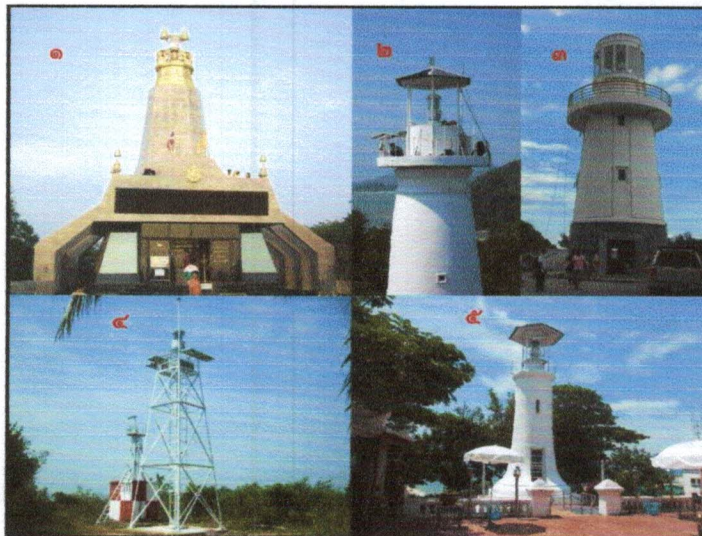
ภาพที่ ๑ ประภาคารและกระโจมไฟที่ติดตั้งตะเกียงระบบเลนส์หมุนพลังงานแสงอาทิตย์
